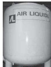
Stickstoff-Tank für das Kühlsystem
